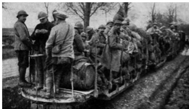
*Transport de ravitaillement par «stortillard» sur voie de 0,60m*
