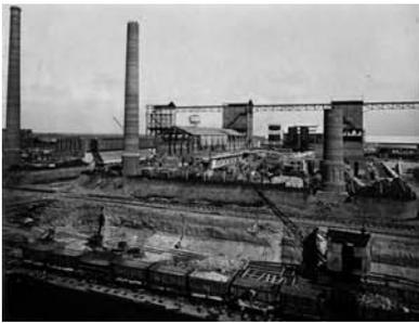
*Vue des tours de stockage de la houille, des batteries de fours à coke et des ateliers de récupération des sous-produits (vue prise du haut fourneau n°2), en juillet 1916.*
