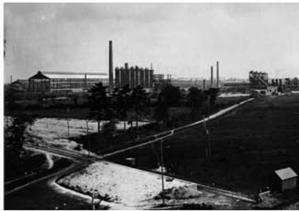
*Vue d'ensemble de l'usine de Caen-Mondeville, de gauche à droite, les silos de stockage de la houille, les cheminées des batteries de fours à coke, charpente et base des hauts fourneaux, les Cowper, en juillet 1916.*
